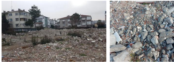
Şekil 1. İnşaat yıkıntı atıkları.
